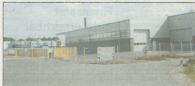
Innovation und Weiterentwicklung: Bei Konrad Stükerjürgen wurde eine kombinierte Technik aus Photovoltaik und Erdwärme realisiert.
