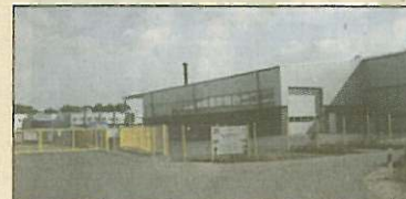
Asphalttemperierung auf dem Firmengelände
